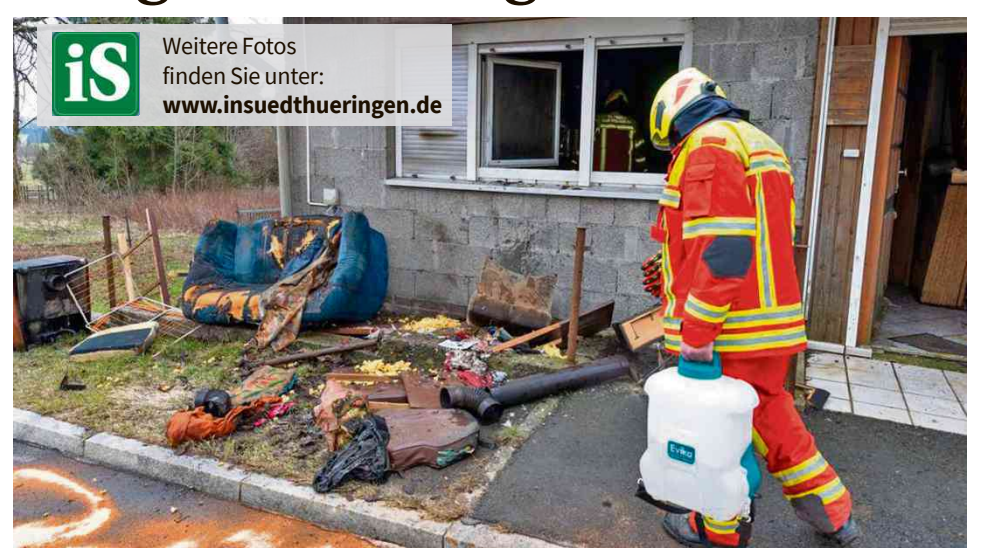
Das vom Brand beschädigte Haus und zerstörtes Mobiliar werden gesichert.
