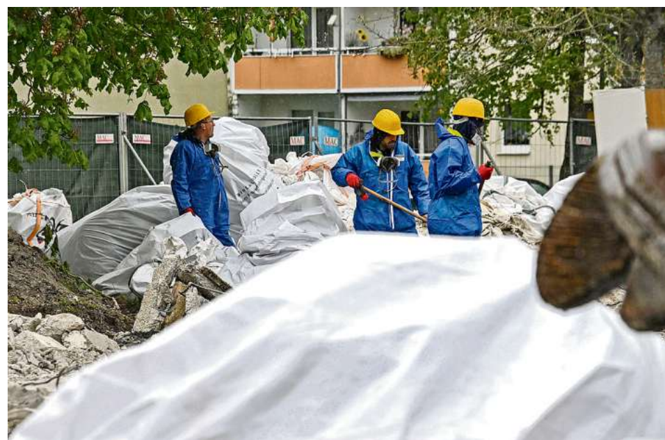
Materialtrennung beim Abriss.
