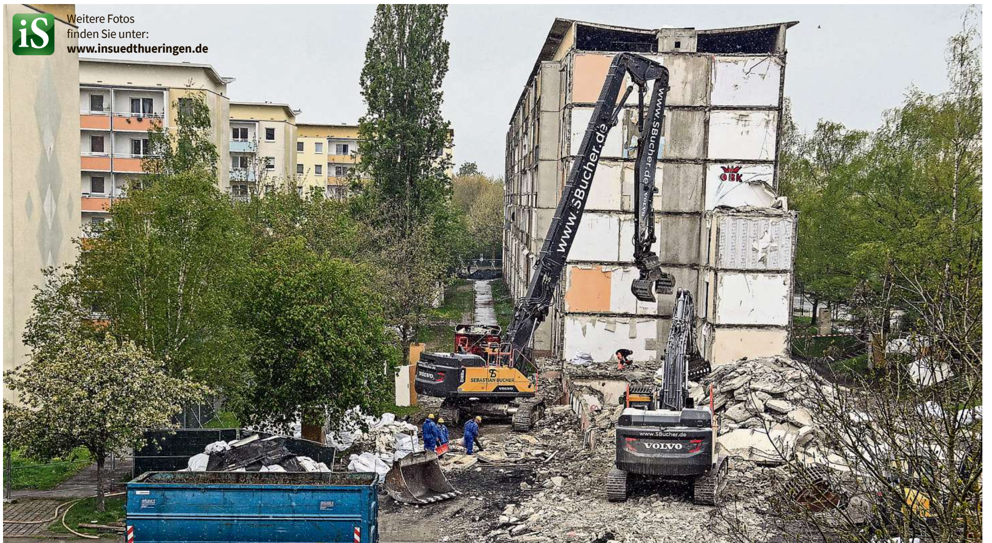
Der Abriss des 150er Wohnblocks im Sonneberger Wolkenrasen, einem Plattenbau, schreitet voran.
